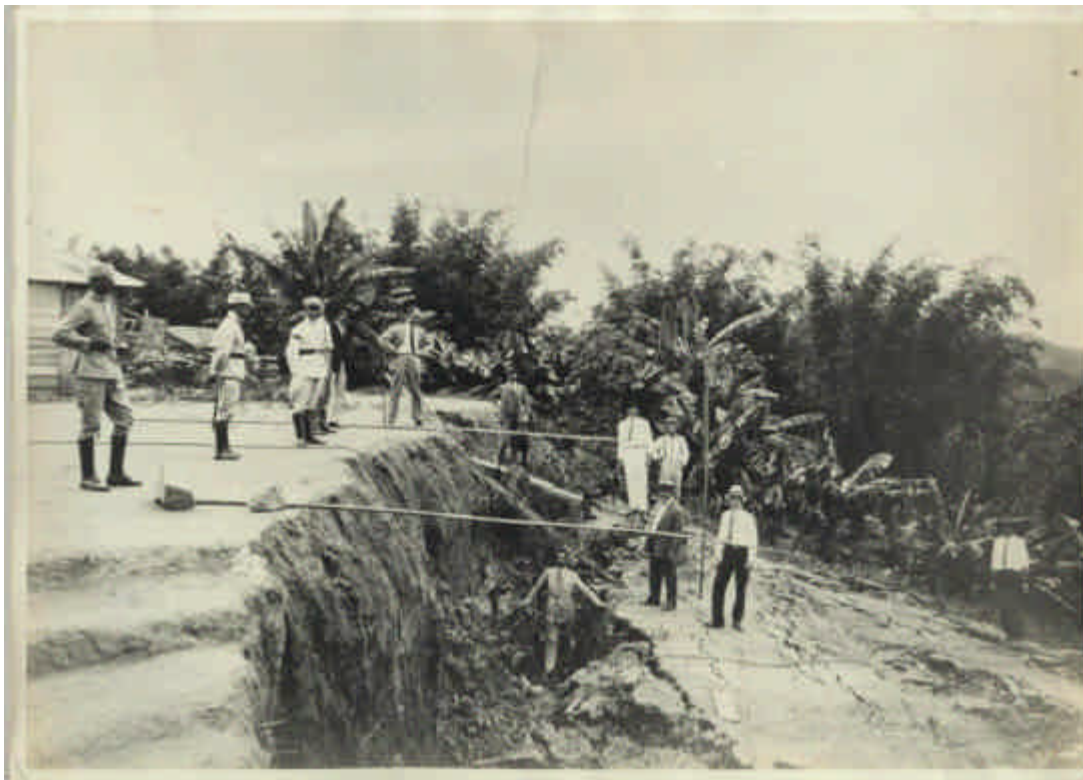
Foto 11. Degrau de abatimento na encosta do Monte Serrat, Santos (SP), em 1928, alguns dias antes da ocorrência do escorregamento que matou 80 pessoas e destruiu parte da antiga Santa Casa (foto do arquivo de C.M.Nunes).
