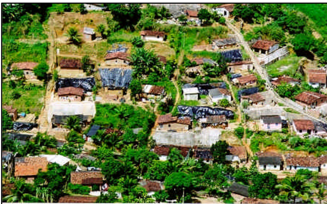
Foto 15. Lonas plásticas cobrindo taludes instáveis no bairro de Casa Amarela, Recife (PE). Foto de M.M. Alheiros.
