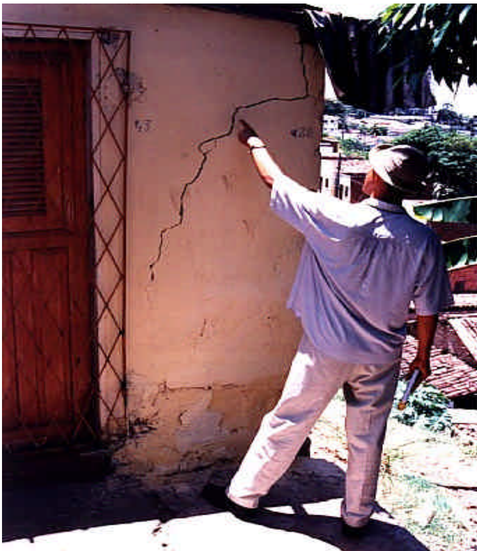
Foto 17. Identificação em campo de evidências iniciais de movimentação do solo para adoção de medidas de prevenção de acidentes. Trinca em moradia produzida por rastejo acelerado por cheia e rebaixamento do nível do rio Acre. Rio Branco (AC), 1995.
