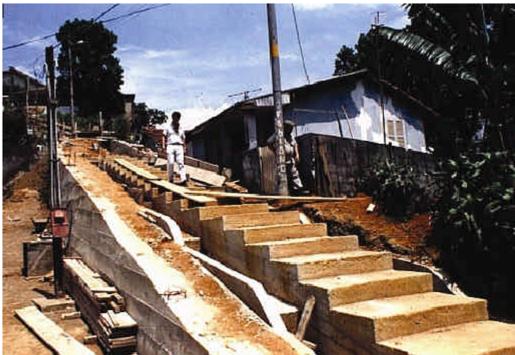
Foto 22. Construção de escadaria da Rua São Manoel, como drenagem de crista da encosta a montante da Rua São Bernardo, Morro São Bento/Jabaquara, 1992.
