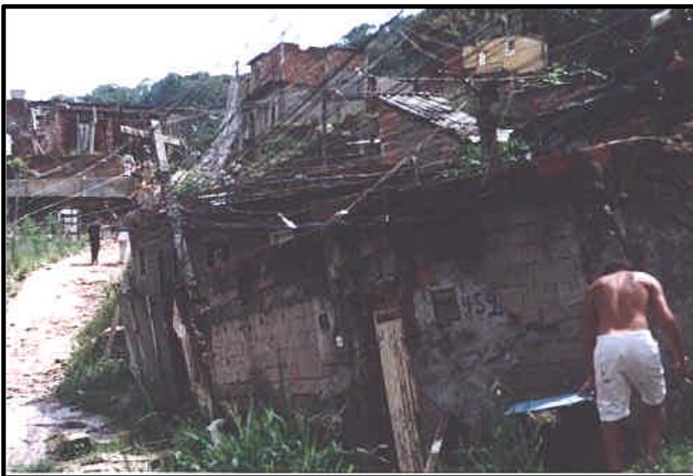
Foto 8. Rastejo em tálus ocupado por favela, instabilizando mais de 200 moradias, Vila Albertina, zona norte de São Paulo (SP), 2001. Observar o basculamento das moradias e a inclinação dos postes, provocados pela movimentação do solo. (Foto de C.E.G. Carneiro).
