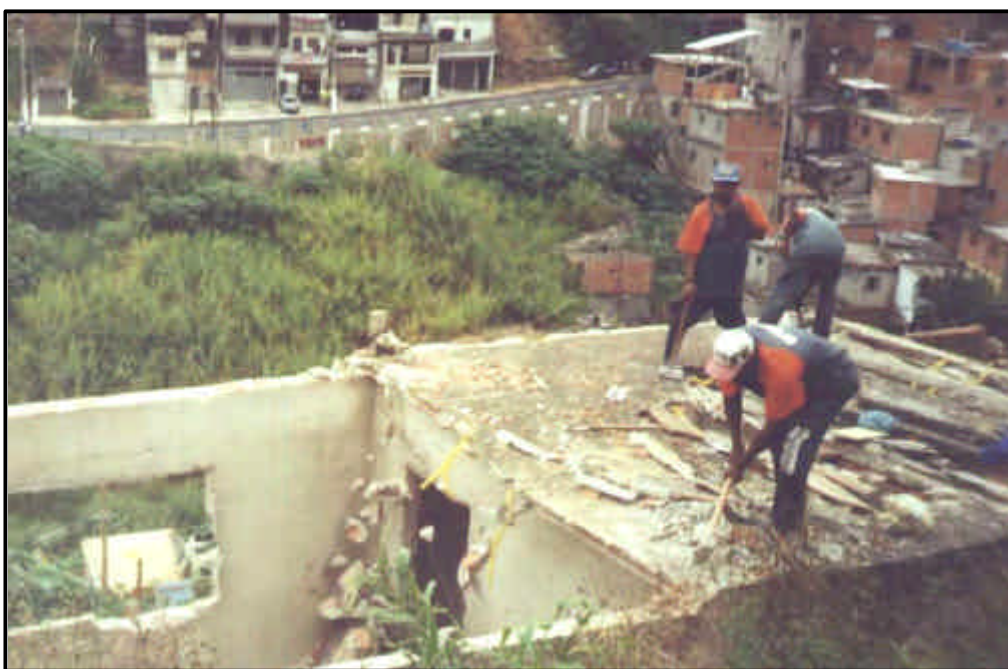
Foto 14. Demolição de moradias em encosta com risco muito alto de escorregamento, associada a programas de reurbanização e regularização de loteamentos. Região sul de São Paulo (SP), 2002.
