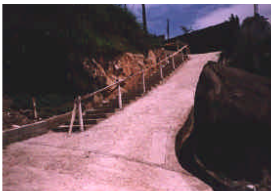
Foto 12. Obra de drenagem associada a escada e rampa de acesso no morro de São Bento, Santos (SP).
