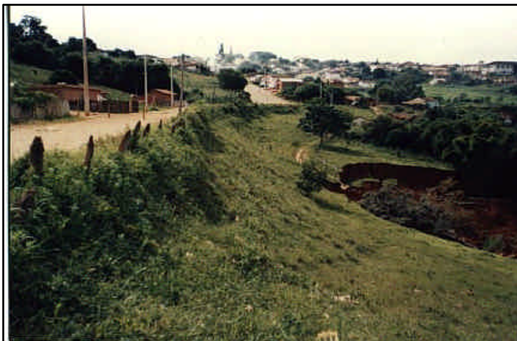
Foto 7. Escorregamento rotacional de aterro executado sobre uma camada de solo orgânico no município de Muzambinho (MG), 1994. (Foto de V.A.Nakazawa).
