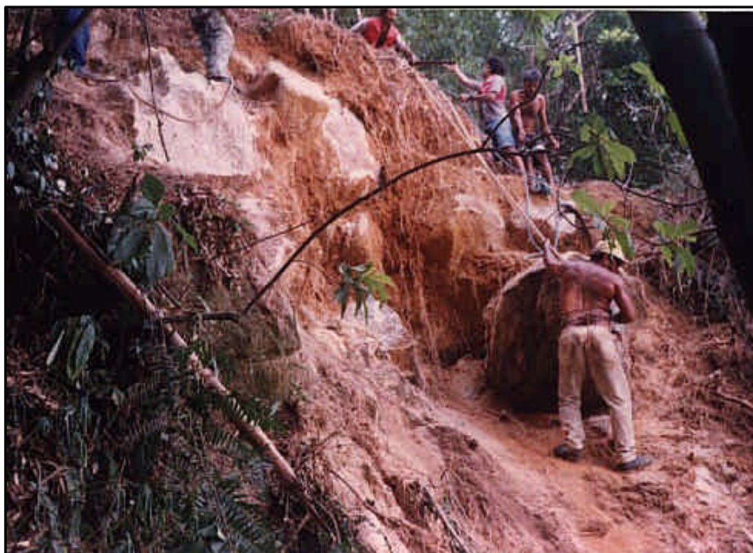
Foto 13. Desmonte de “ninho” de blocos rochosos instáveis no morro do Jabaquara, Santos (SP).
