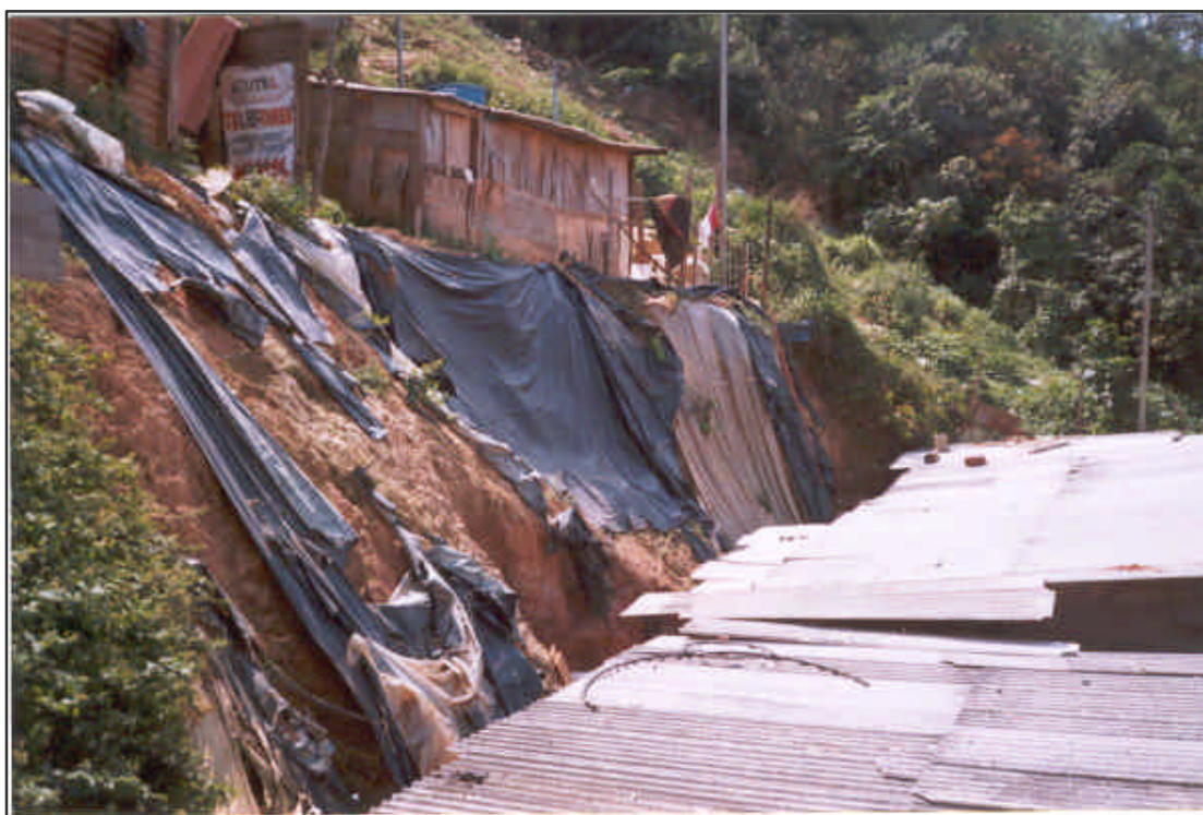
Foto 6. Escorregamento superficial de solo em talude de corte, Jardim Paraná, Freguesia do Ó, São Paulo (SP), outubro de 2001 (foto de F.A.N. Silva)
